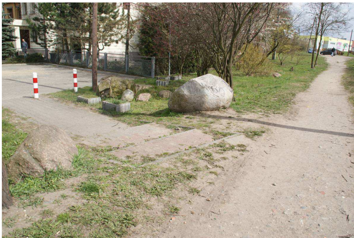
Fot. 3. Istniejące schody terenowe
