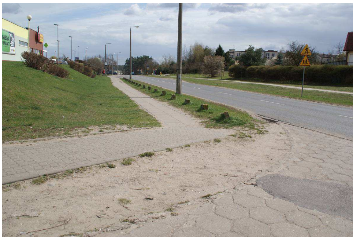
Fot. 8. Istniejący chodnik
